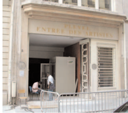
8, rue Daru (travaux de 2006)
